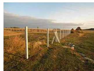
3 sor feszítőhuzalt követően felrakják a drótfonatot.
