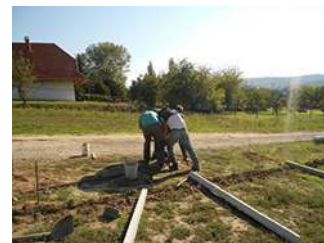
Ha kemény a talaj, akkor négyen is kapaszkodnak a fúróba.
