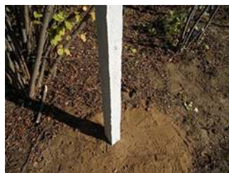
Ezt követően, minden oszlopot vízmértékkel állítanak be, és tömörítenek vissza.
