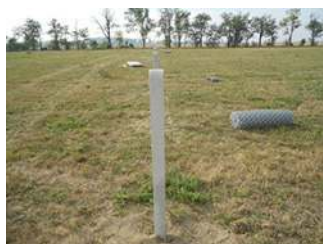
Ha belenéznek a betonoszlop sorba, ezt a képet kell látniuk.
